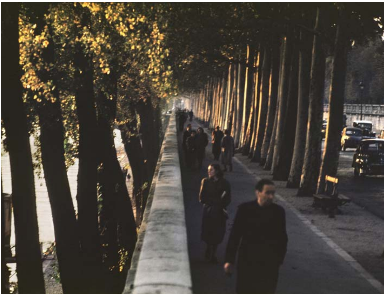
Quai des Tuileries, Paris, 1954
